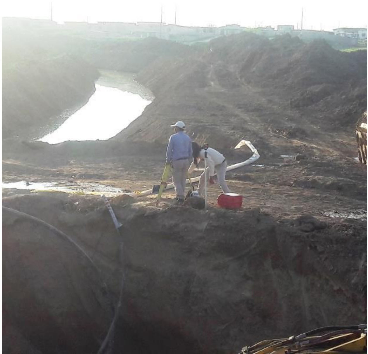
شکل ۱۲- نمایی از خاک برداری برای انتقال جریان از گرگان رود از طریق بند ولی به حوضه رودخانه اترک و قطع و کاهش جریان گرگان رود در پایین دست (تاریخ ۱۳۹۸/۱/۲۴)
