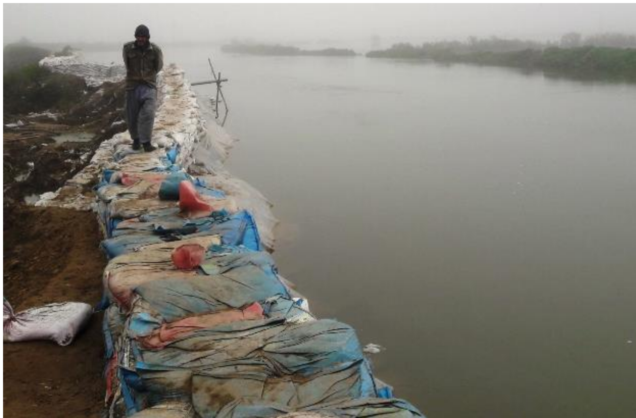
شکل ۱۰- افزایش ارتفاع دیواره های کناری رودخانه قره سو در محل روستای نیازآباد شهرستان بندر ترکمن با هدف جلوگیری از آب گرفتگی مناطق مسکونی (تاریخ ۱۳۹۸/۱/۲۴)
