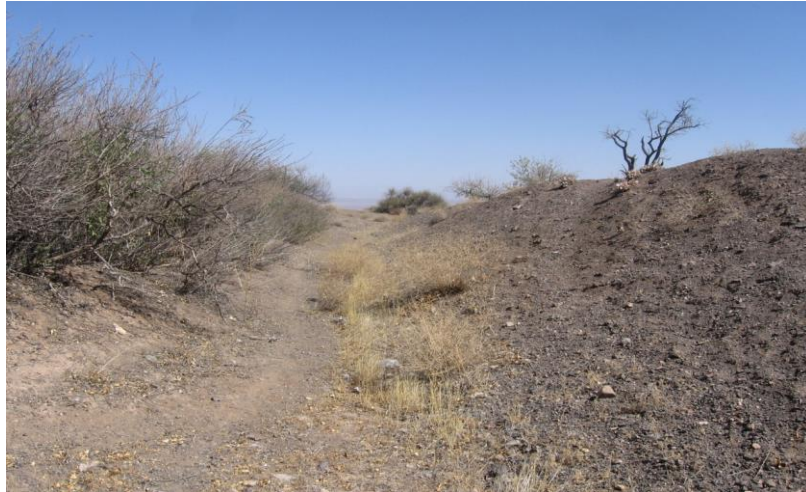
شکل ۴- نهر احداث شده برای انتقال سیلاب که با درختچه هند بید تثبیت شده است
