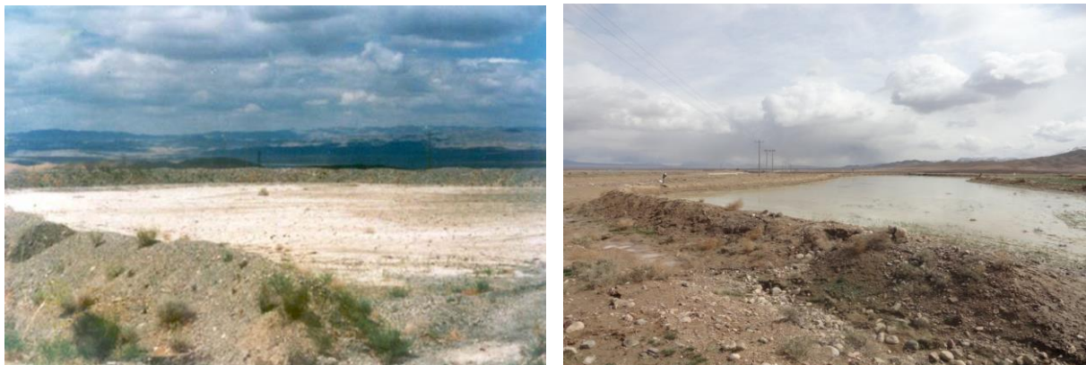
شکل ۹- نمای یک بندسار در زمان آبیگری و بعد از نفوذ آب به داخل خاک (رسوبات باقیمانده بر روی سطح نقش اصلی در اصلاح و نیز رساندن مواد مغذی به خاک را بر عهده دارد).
