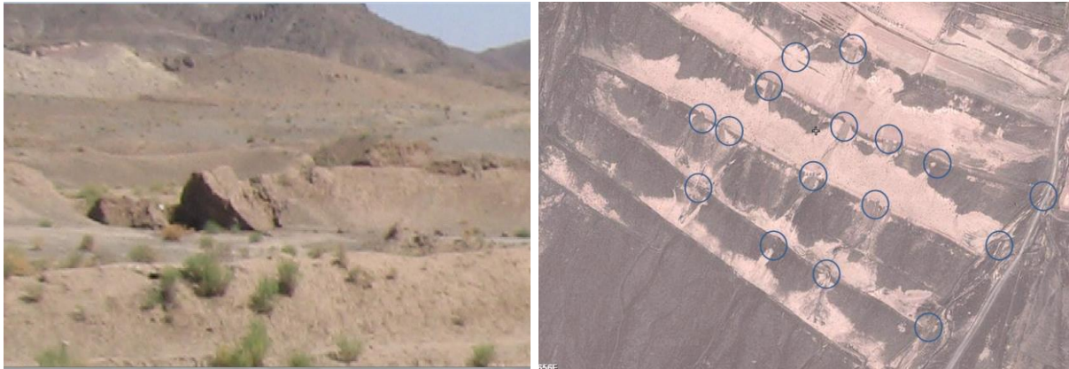
شکل ۱۴- تخریب زنجیره‌ای بندسارها (راست) نمای نزدیک قسمتی از یک بند تخریب شده (چپ)
