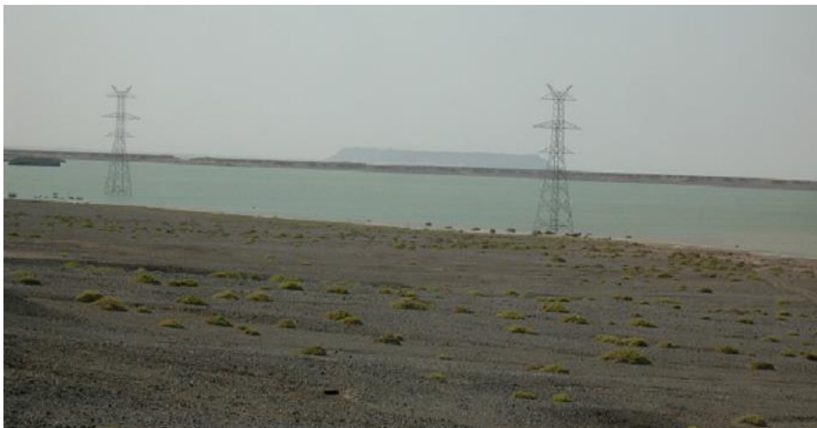
شکل ۸- مخزن ذخیره سیلاب‌های رودخانه بندن در غرب دریاچه هامون
