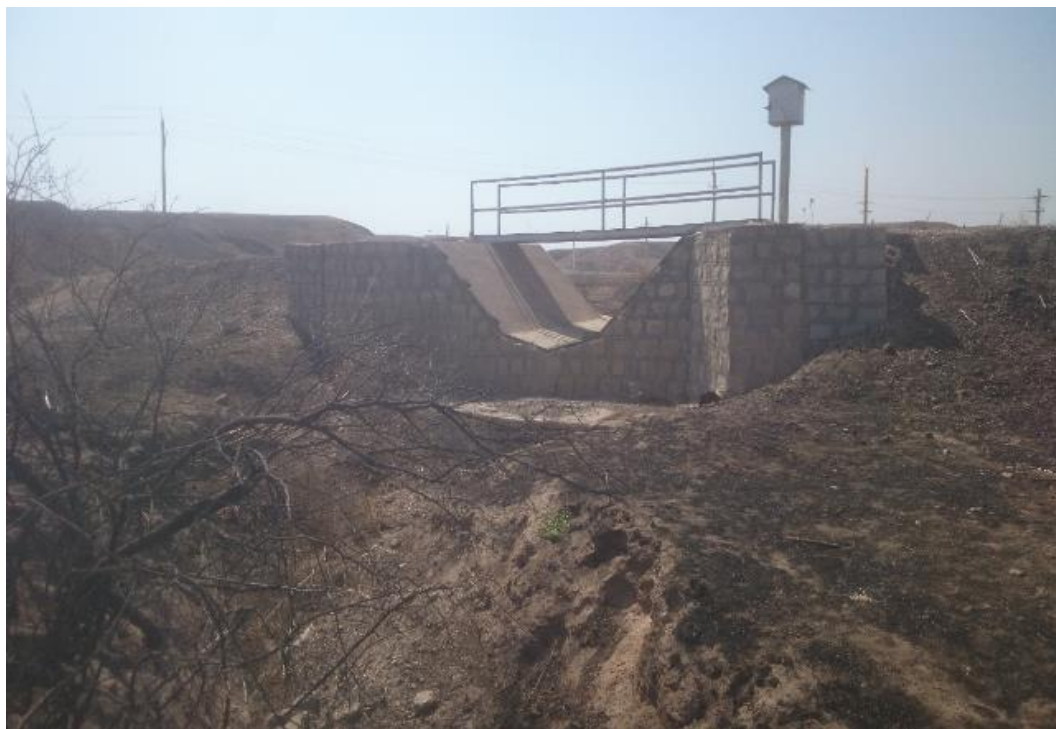
شکل ۱۸- ایستگاه هیدرومتری پایاب حوضه شاهد- دید از پایاب به سراب (مهرماه ۱۳۹۹)
