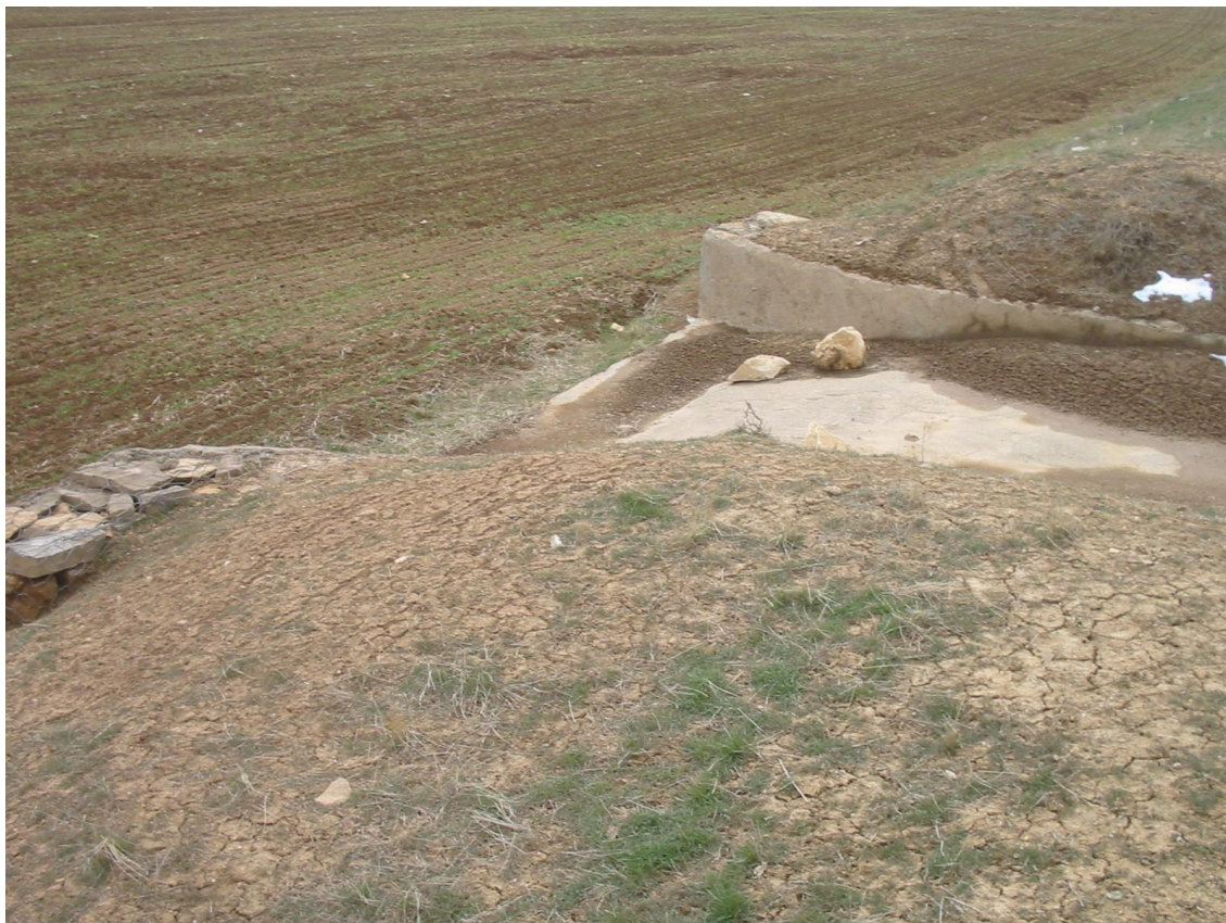
شکل ۳۲- تخریب کلی سنگ‌چین حفاظتی دروازه کانال پخش سوم P2-3 از کانال گسترشی دوم G2 (فرهادی، ۱۳۹۷)
