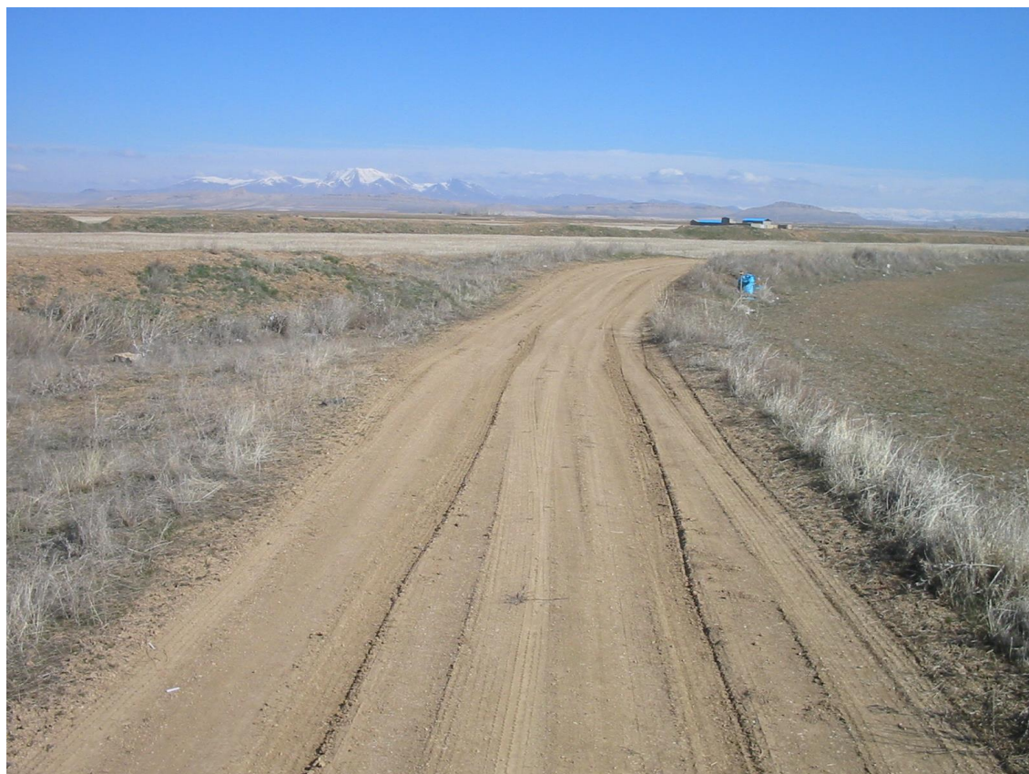
شکل ۸۱- تسطیح خاکریز و احداث جاده بر روی کانال پخش اول P5-1 از کانال گسترشی پنجم G5 (فرهادی، ۱۳۹۷)
