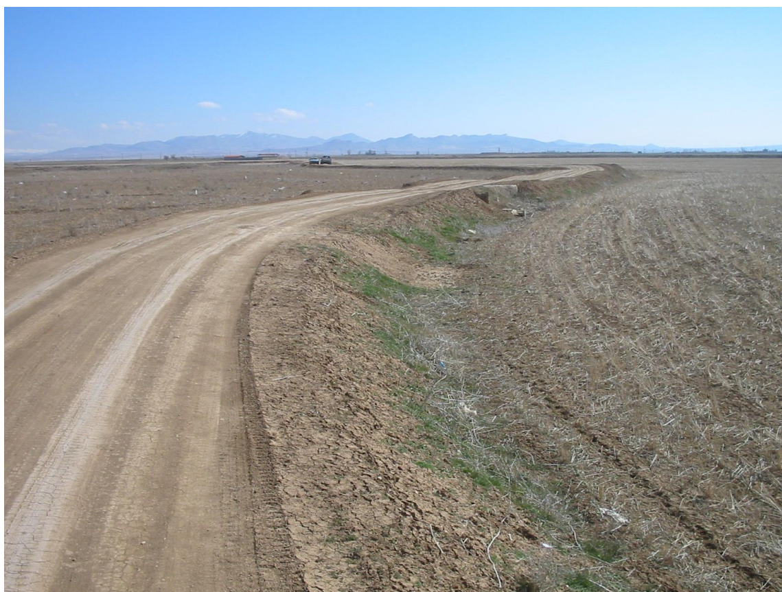
شکل ۷۲- تسطیح خاکریز، احداث جاده و مدفون شدن دروازه کانال پخش سوم P4-3 از کانال گسترشی چهارم G4 (فرهادی، ۱۳۹۷)
