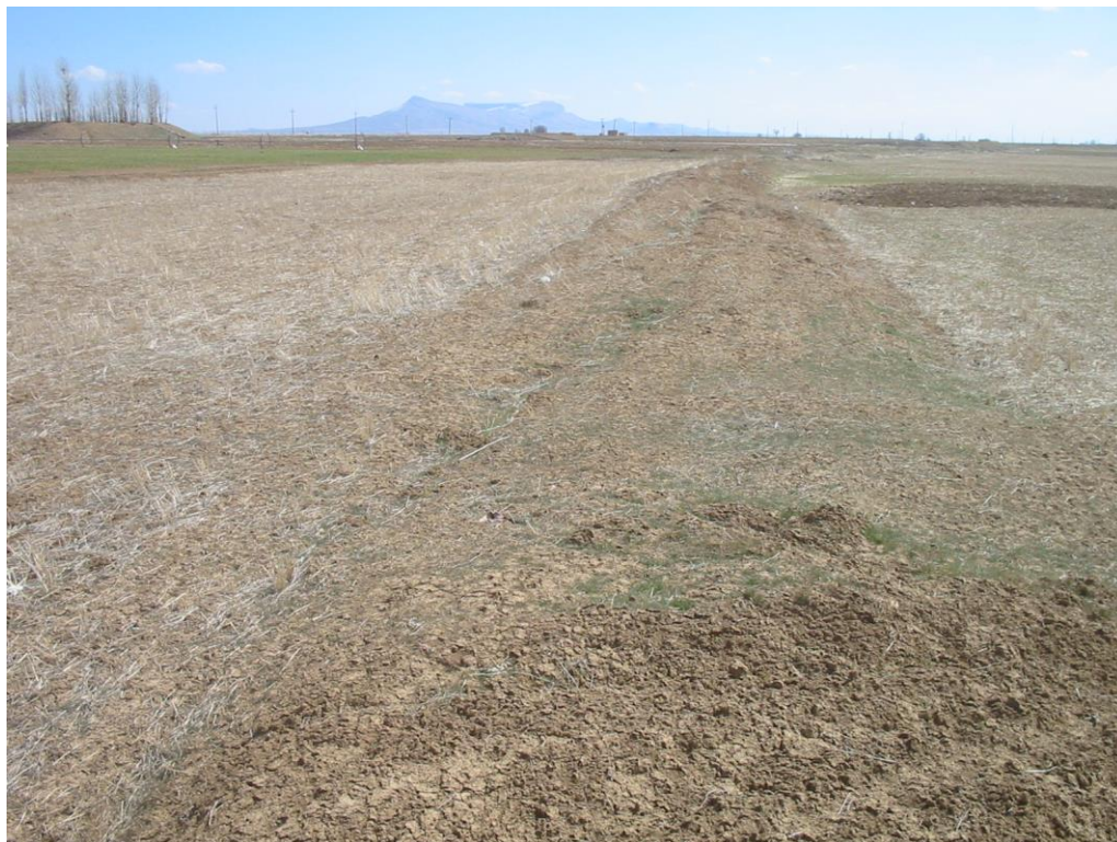
شکل ۵۷- تخریب کلی کانال پخش دوم P3-3 از کانال گسترشی سوم G3 (فرهادی، ۱۳۹۷)
