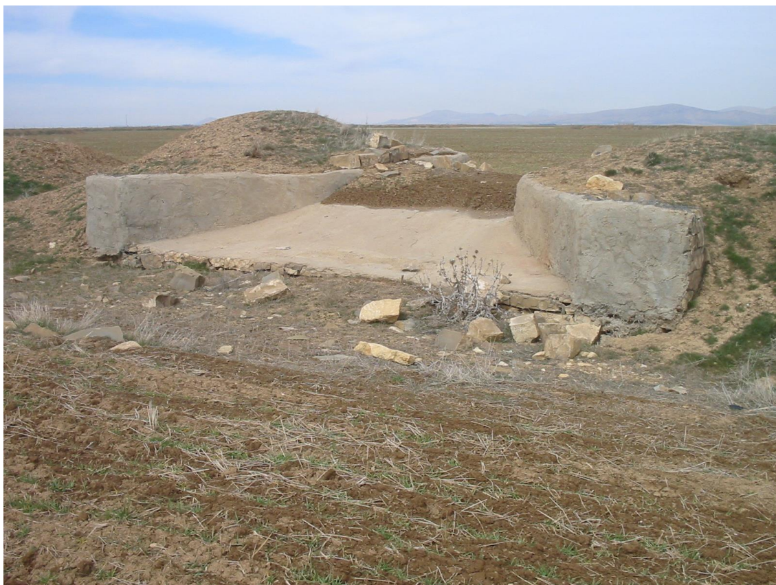
شکل ۳۲- تخریب کلی سنگ‌چین حفاظتی دروازه کانال پخش سوم P2-3 از کانال گسترشی دوم G2 (فرهادی، ۱۳۹۷)
