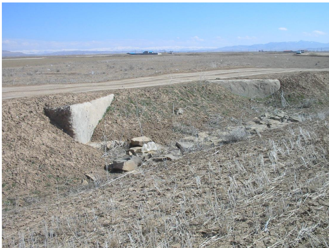
شکل ۷۳ - تسطیح خاکریز، احداث جاده و مدفون شدن دروازه کانال پخش سوم P4-3 از کانال گسترشی چهارم G4 (فرهادی، ۱۳۹۷)
