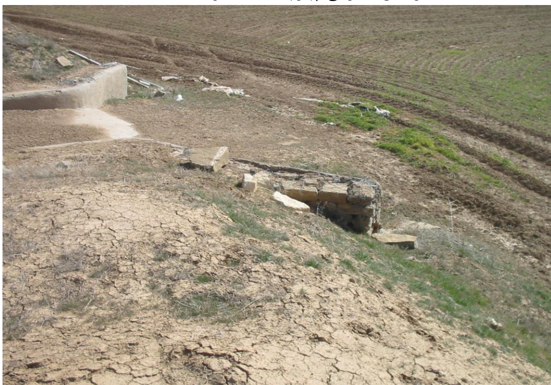
شکل ۶۶- تخریب جزئی سنگ‌چین حفاظتی دروازه کانال پخش اول P4-1 از کانال گسترشی چهارم G4 (فرهادی، ۱۳۹۷)
