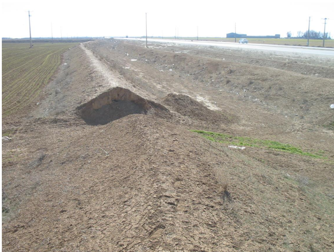
شکل ۶۵- تخریب جزئی دیواره کانال اصلی در محل جداشدن کانال پخش اول P4-1 از کانال گسترشی چهارم G4 (فرهادی، ۱۳۹۷)
