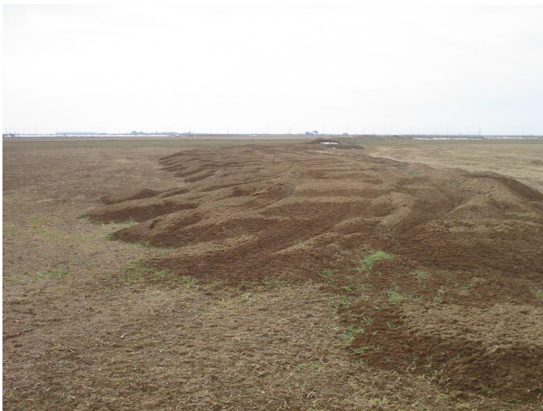
شکل ۴۷ - تخریب کلی کانال پخش اول P3-1 از کانال گسترشی سوم G3 (فرهادی، ۱۳۹۷)
