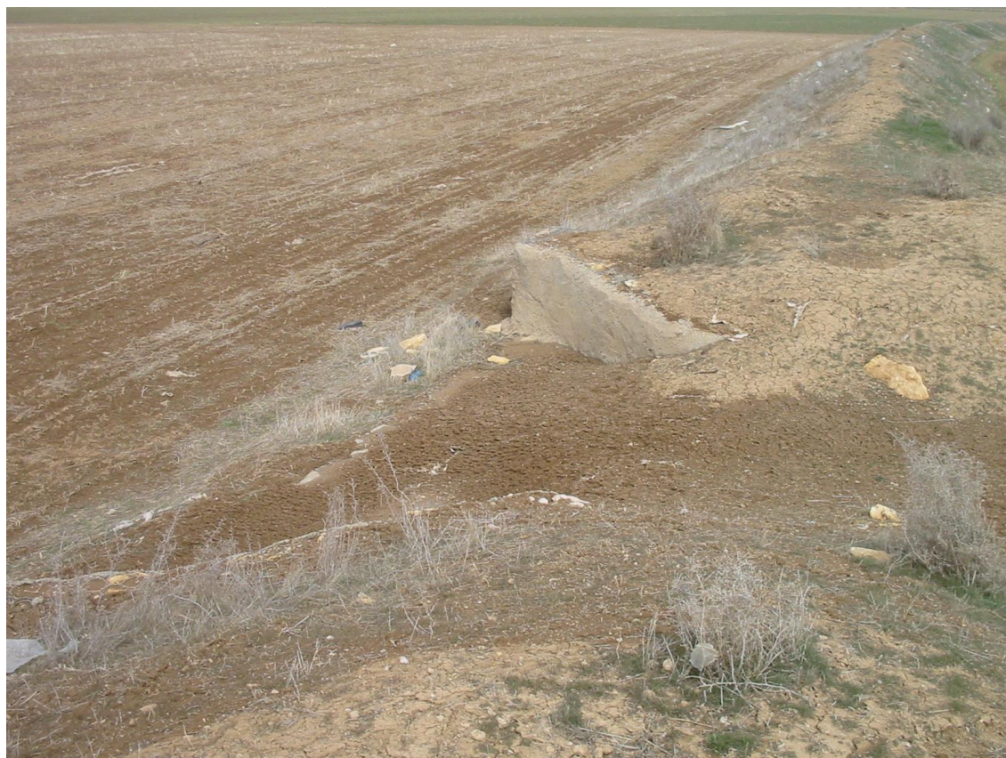
شکل ۲۸- تخریب جزئی و مسدود شدن دروازه کانال پخش دوم P2-2 از کانال گسترشی دوم G2 (فرهادی، ۱۳۹۷)
