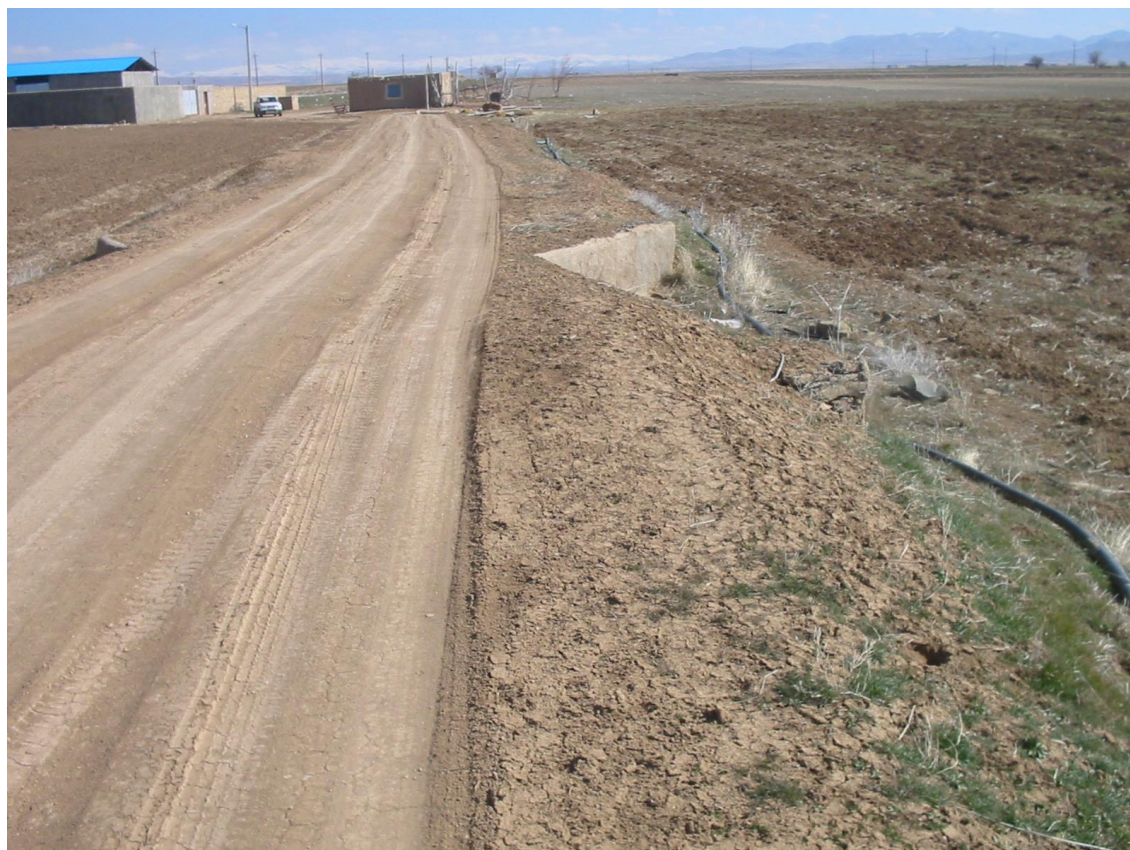
شکل ۷۵- تسطیح خاکریز، احداث جاده و مدفون شدن دروازه کانال پخش سوم P4-3 از کانال گسترشی چهارم G4 (فرهادی، ۱۳۹۷)
