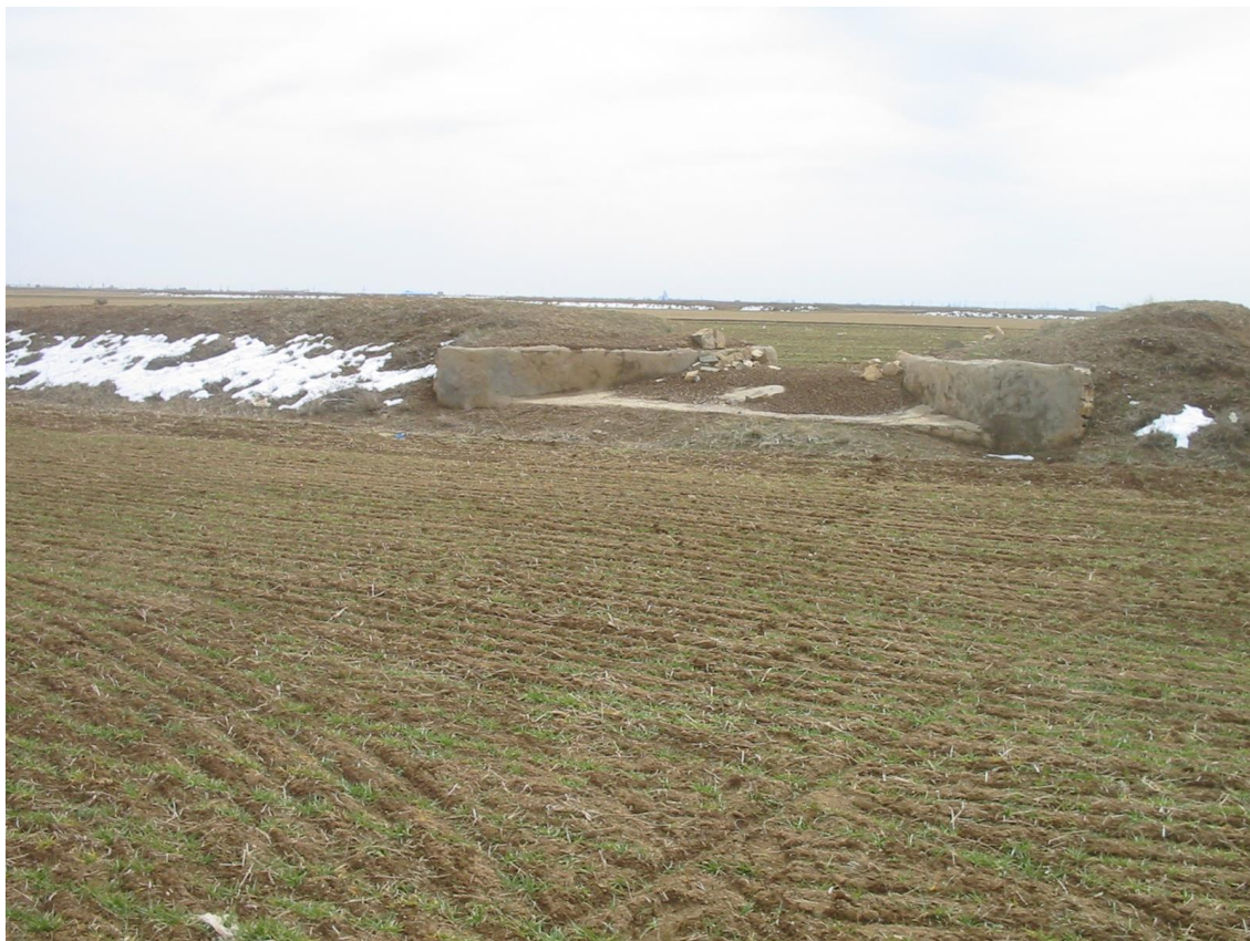
شکل ۲۵- تخریب جزئی سنگ‌چین حفاظتی دروازه کانال پخش دوم P2-2 از کانال گسترشی دوم G2 (فرهادی، ۱۳۹۷)
