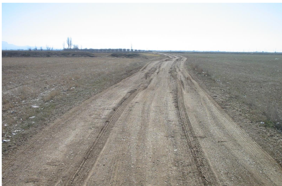
شکل ۸۲- تسطیح خاکریز و احداث جاده بر روی کانال پخش اول P5-1 از کانال گسترشی پنجم G5 (فرهادی، ۱۳۹۷)
