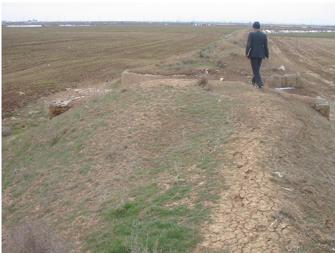
شکل ۲۵- تخریب جزئی سنگ‌چین حفاظتی دروازه کانال پخش دوم P2-2 از کانال گسترشی دوم G2 (فرهادی، ۱۳۹۷)
