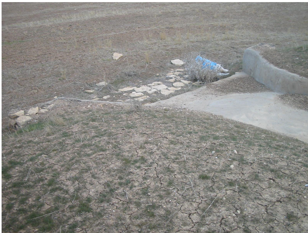
شکل ۴۸- تخریب جزئی سنگ چین حفاظتی دروازه کانال پخش دوم P3-2 از کانال گسترشی سوم G3 (فرهادی، ۱۳۹۷)
