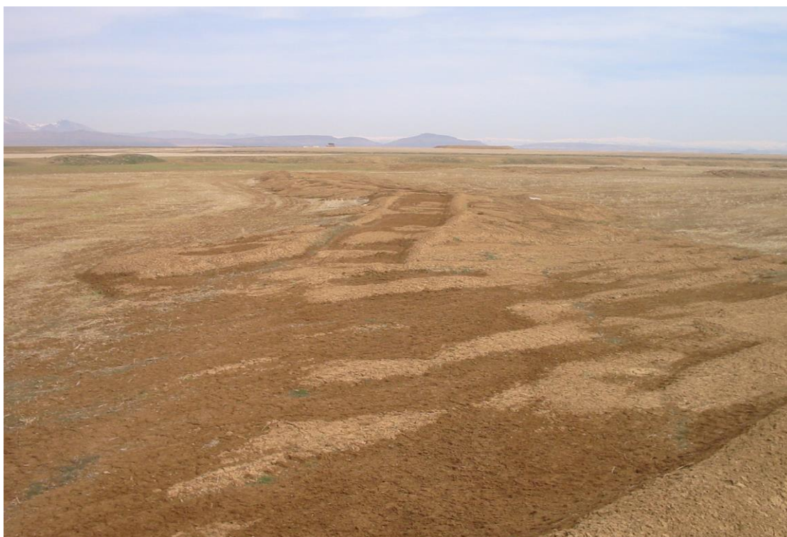
شکل ۴۶- تخریب کلی کانال پخش اول P3-1 از کانال گسترشی سوم G3 (فرهادی، ۱۳۹۷)
