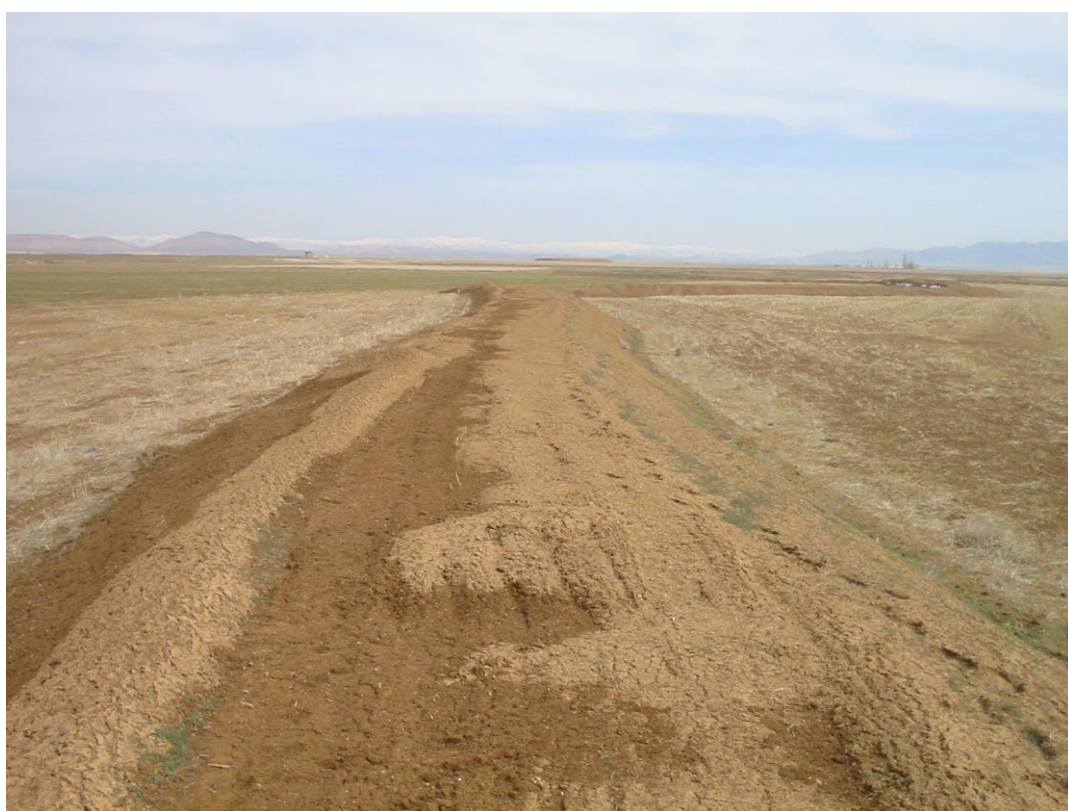
شکل ۴۰- تخریب کلی کانال گسترشی سوم G3 (فرهادی، ۱۳۹۷)
