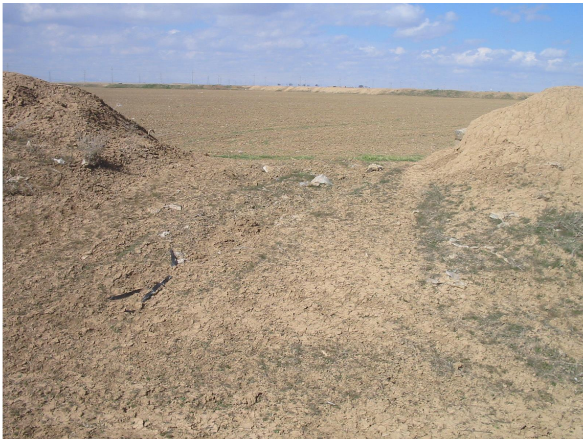
شکل ۶۷- تخریب جزئی کانال پخش اول P4-1 از کانال گسترشی چهارم G4 (فرهادی، ۱۳۹۷)
