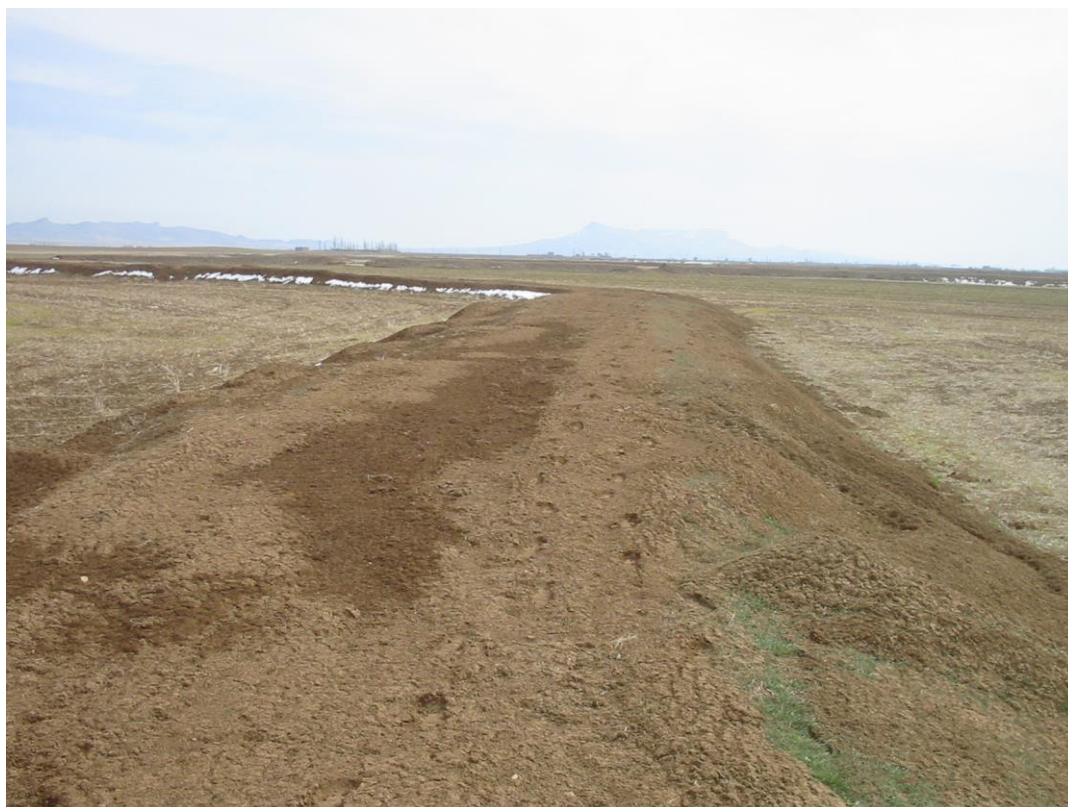
شکل ۳۹- تخریب کلی کانال گسترشی سوم G3 (فرهادی، ۱۳۹۷)
