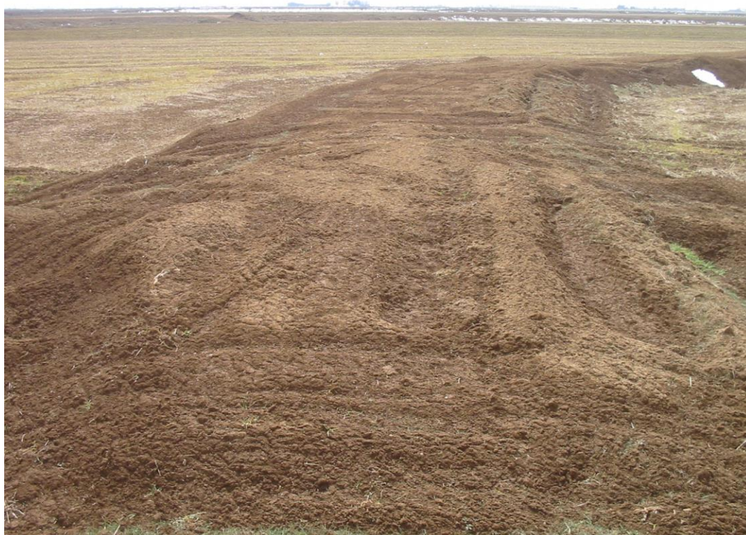
شکل ۳۸- تخریب کلی کانال گسترشی سوم G3 (فرهادی، ۱۳۹۷)
