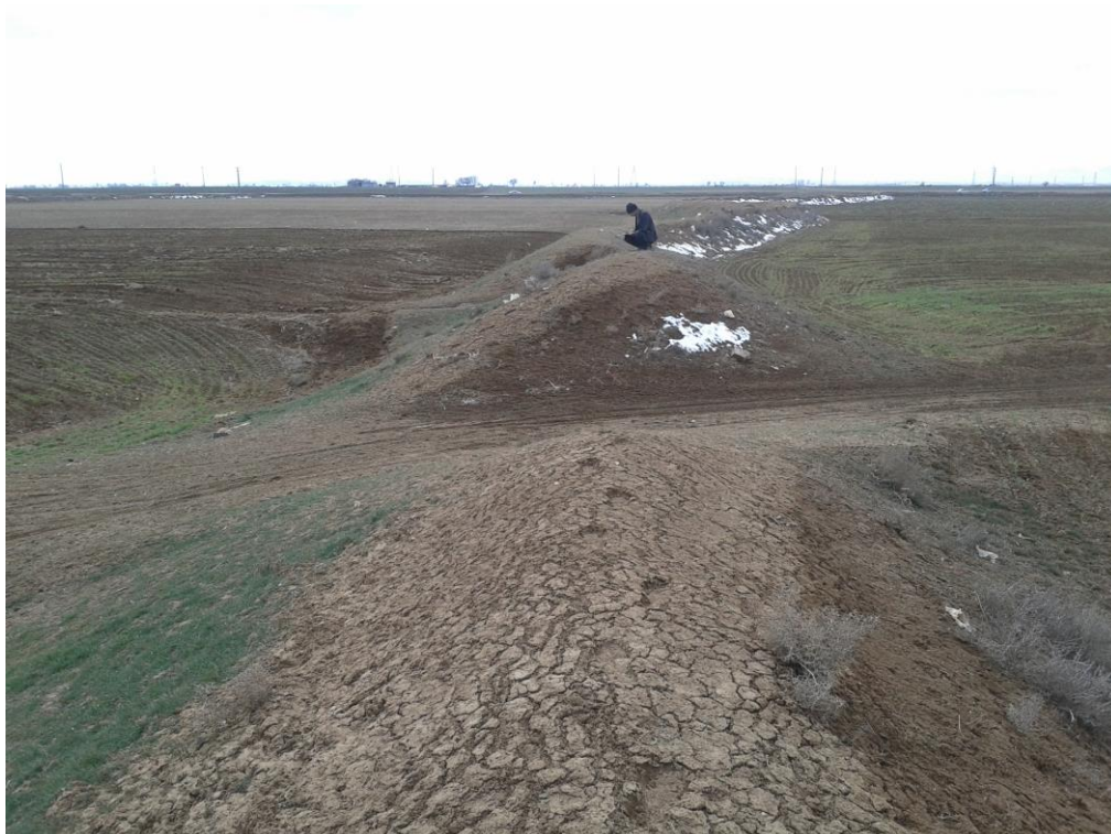
شکل ۱۸- تخریب جزئی خاکریز کانال گسترشی دوم G2 (فرهادی، ۱۳۹۷)
