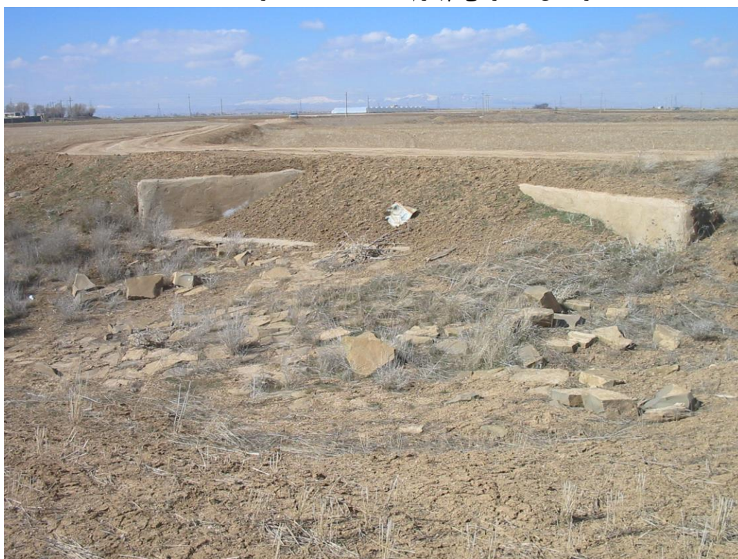
شکل ۷۴ - تسطیح خاکریز، احداث جاده و مدفون شدن دروازه کانال پخش سوم P4-3 از کانال گسترشی چهارم G4 (فرهادی، ۱۳۹۷)
