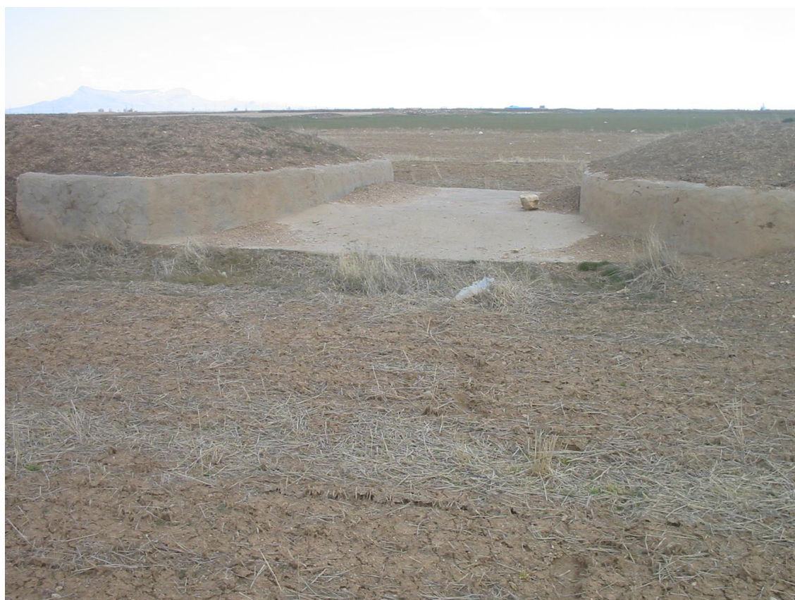
شکل ۴۸- تخریب جزئی سنگ چین حفاظتی دروازه کانال پخش دوم P3-2 از کانال گسترشی سوم G3 (فرهادی، ۱۳۹۷)
