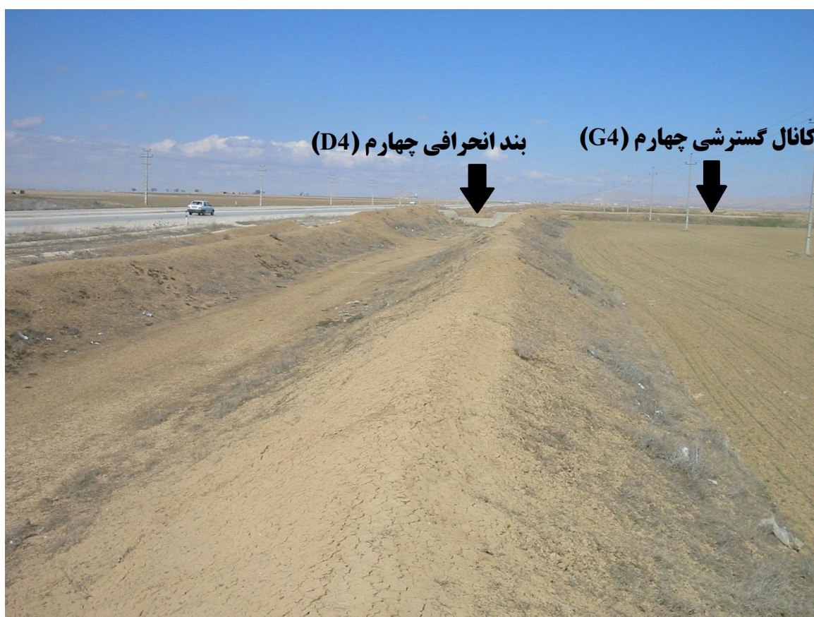
شکل ۶۲- نمای بند انحرافی چهارم (D4) از جنوب به شمال (فرهادی، ۱۳۹۷)
