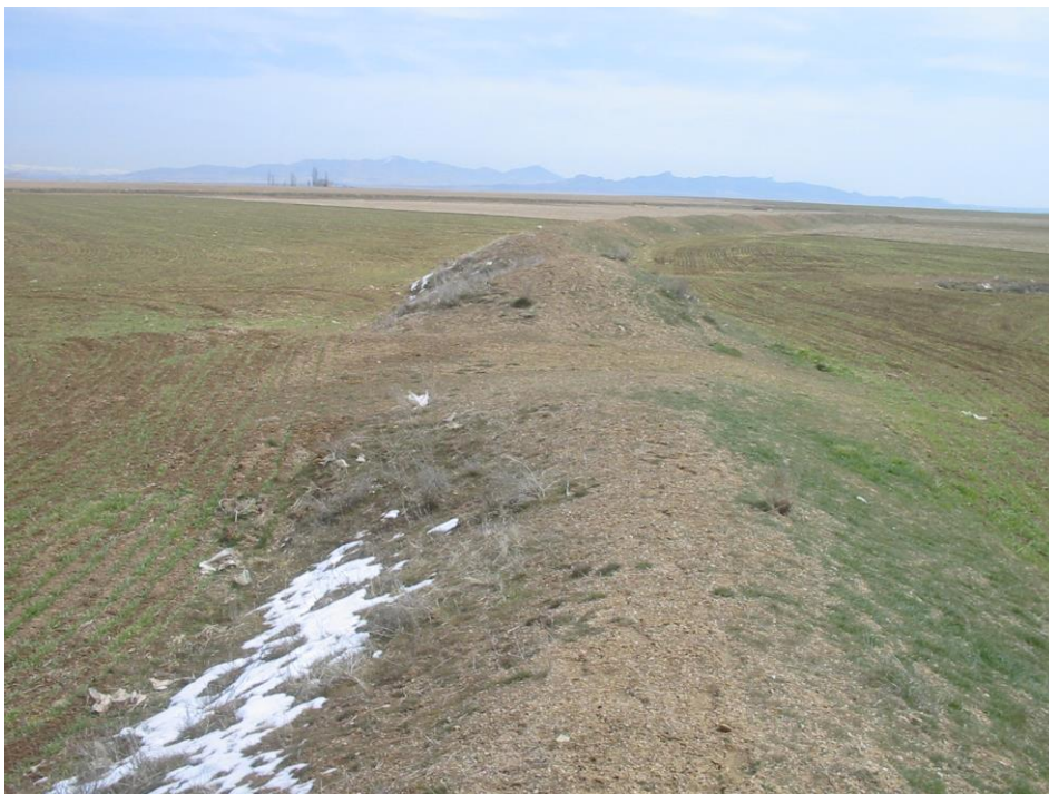
شکل ۳۷- تخریب جزئی کانال گسترشی سوم G3 (فرهادی، ۱۳۹۷)
