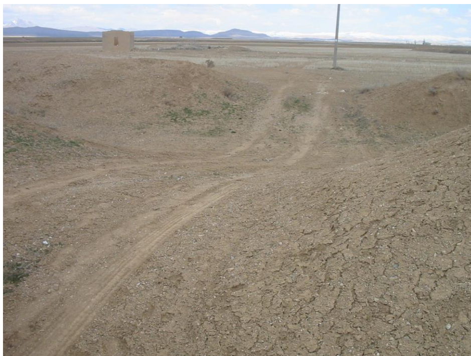
شکل ۵۲- تخریب جزئی دیواره کانال اصلی در محل جدا شدن کانال پخش دوم P3-2 از کانال گسترشی سوم G3 (فرهادی، ۱۳۹۷)
