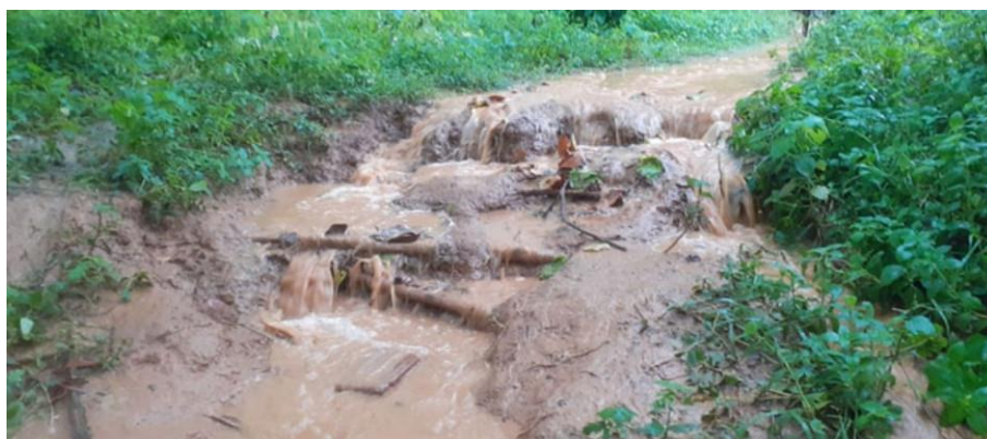
شکل ۲-۵- فرسایش‌های کنار رودخانه‌ای
