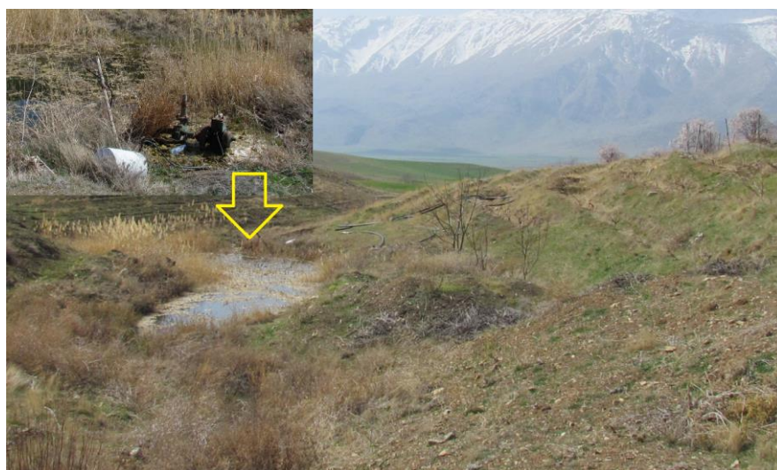
شکل ۸- جمع آوری آب سطحی و زیرقشری در مسیر آبراهه فصلی و پمپاژ به بالادست (منبع عکس:
