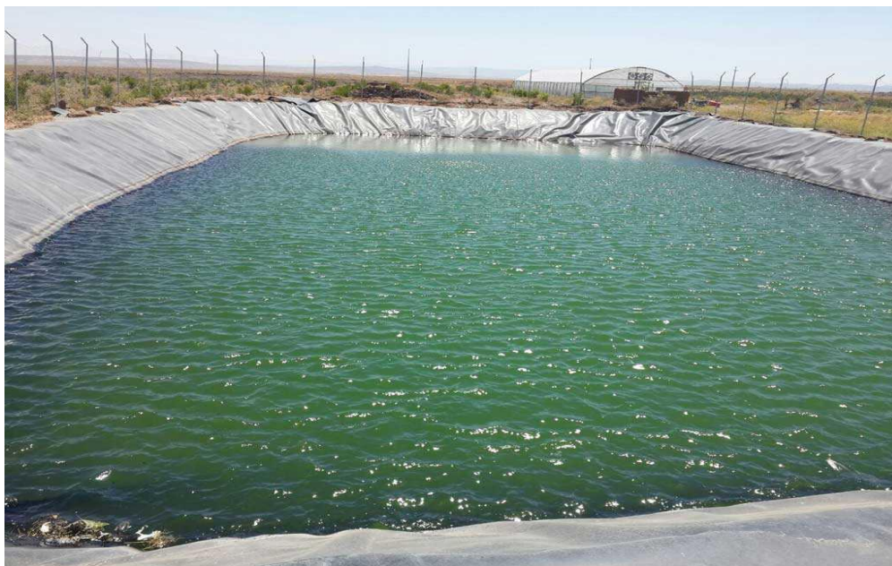
شکل ۴- استخر ژئوممبرین ذخیره آب کشاورزی (منبع عکس: شرکت وینداور، ۱۴۰۳)
