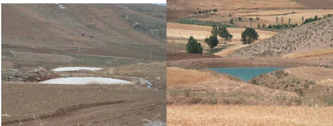
شکل ۱۱- تورکینست یا استخر ذخیره آب کشاورزی، منبع تأمین آب، جمع آوری رواناب ناشی از بارندگی
