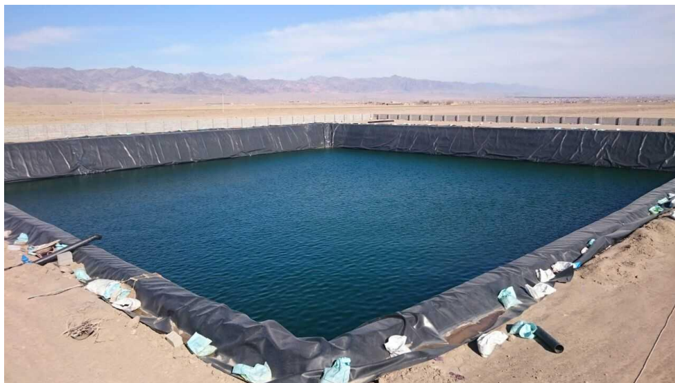
شکل ۱۴-نمایی از اجرای استخر ذخیره آب کشاورزی با پوشش ژئوممبرین (منبع عکس: شرکت وینداور،
