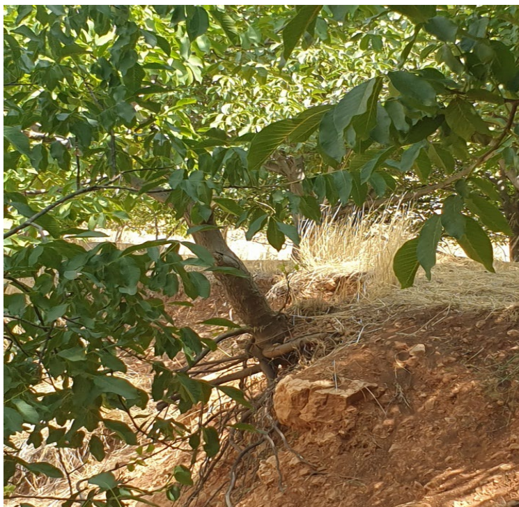
شکل ۹- خروج ریشه از دامنه در اثر جابجایی زمین ناشی از وقوع زمین لغزش
