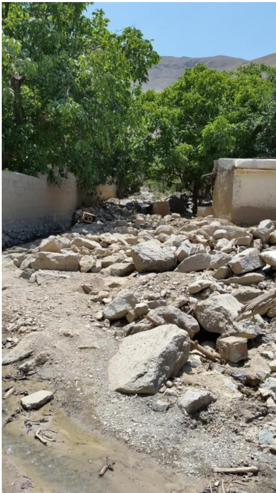
شکل ۳۶- نمایی از بستر پرشده رودخانه و قرار گرفتن بستر در تراز بالاتر از کف اطاق‌های واحد مسکونی
