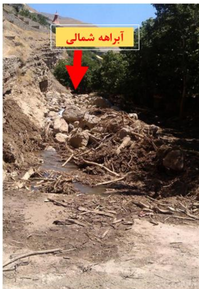
شکل ۷- آثار داغاب سیل آبراهه جنوبی بر روی پل و پیشروی آن به آبراهه شمالی
