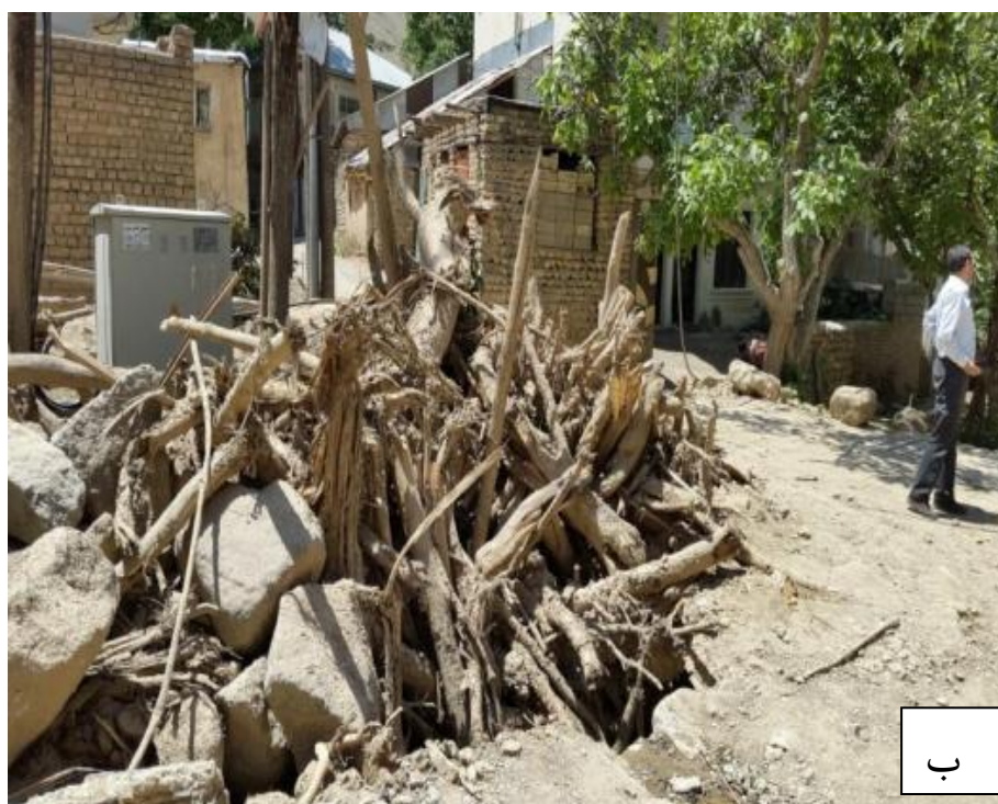
شکل ۳۱- ورودی دهانه پل در وسط روستای سیجان پر شده از سنگ و تنه‌های درختان حمل شده از بالادست (الف: دهانه ورودی پر شده است، ب: دهانه ورودی پر و پل نیز تخریب شده است).
