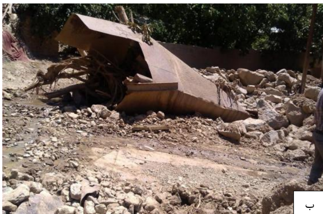
شکل ۳۴- نمایی از مسیر پرشده رودخانه در قسمت بالایی روستای سیجان (الف بستر رودخانه پرشده هم سطح جاده و زمین های اطراف و ب پل تخریب شده و انتقال یافته از بالادست)
