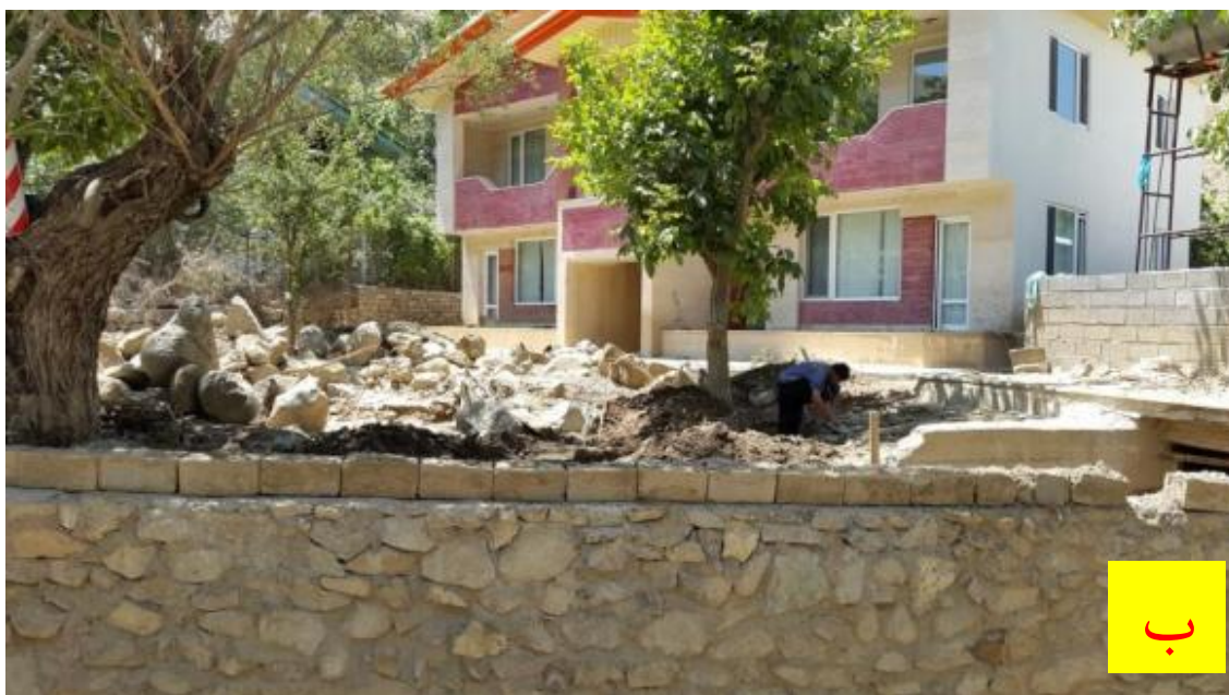
شکل ۲۱- نمایی از داخل اتاق و حیاط برخی واحدهای مسکونی پس از تخریب دیوار و ورود سیل به داخل اتاق - ها (الف- نمایی از داخل اتاق واحد مسکونی پس از تخریب دیوار و ورود سیل به داخل اتاق ها و ب: نمایی از مواد مختلف حمل شده توسط سیل در محوطه حیاط یک واحد مسکونی)
