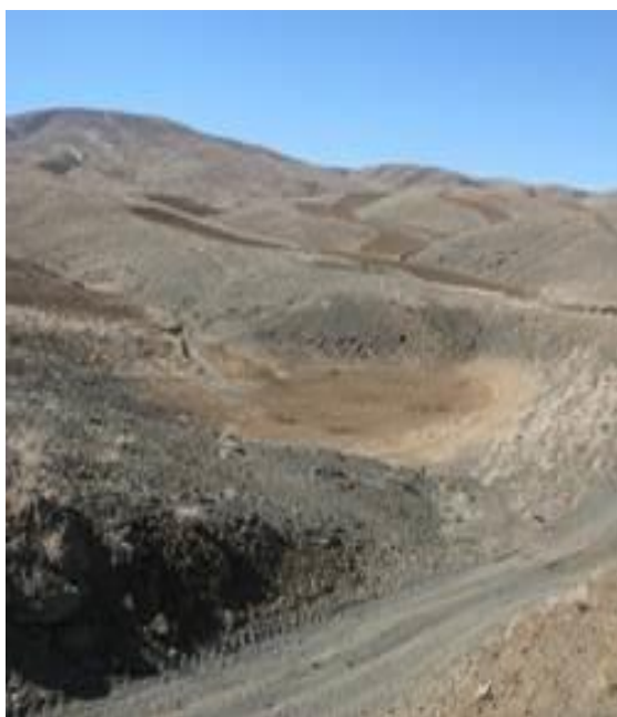
شکل (۲-۱۴): بند خاکی حوضه شماره دو کاظم آباد
