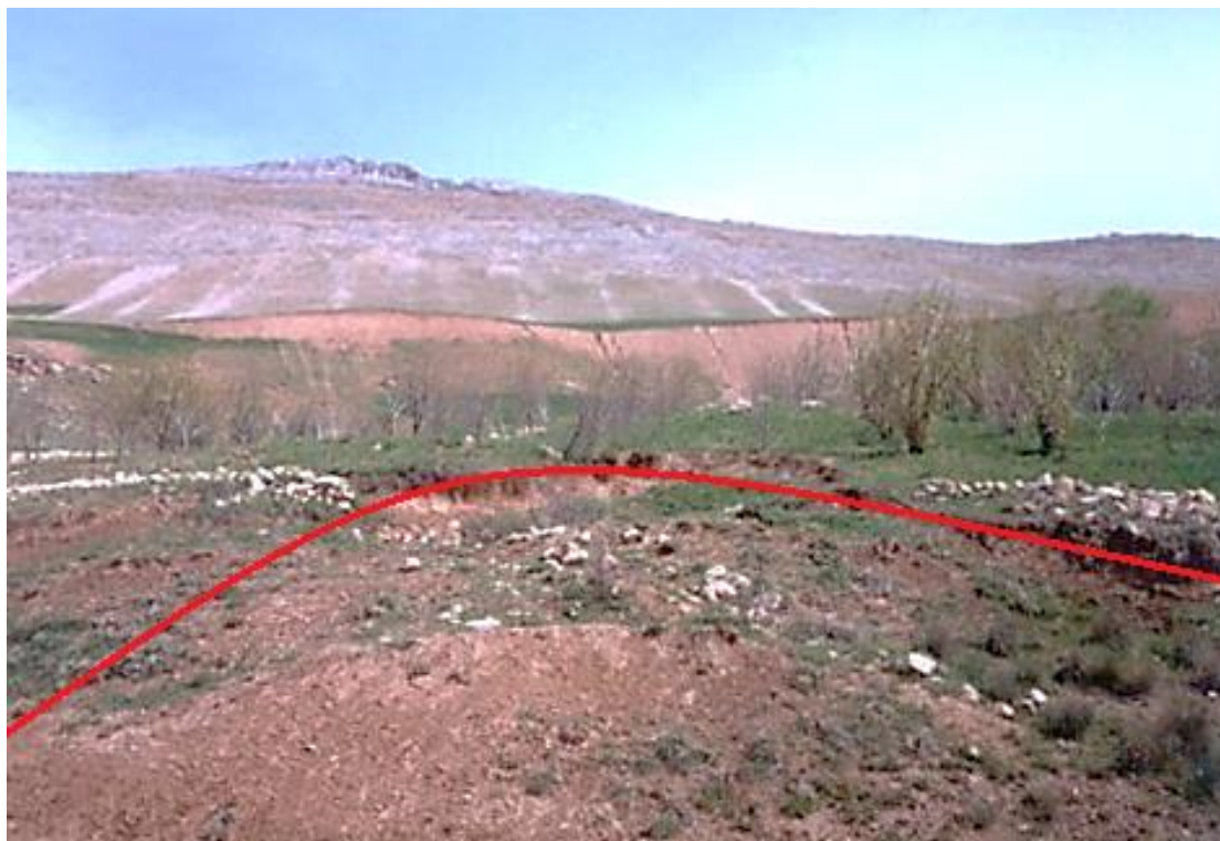
شکل ۶- مرز شمالی لغزش (تاج لغزش)
