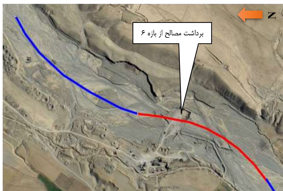
شکل ۸- نمایی از برداشت مصالح از بستر رودخانه از بازه ۶ واقع در پایین‌دست سازه کف‌بند
