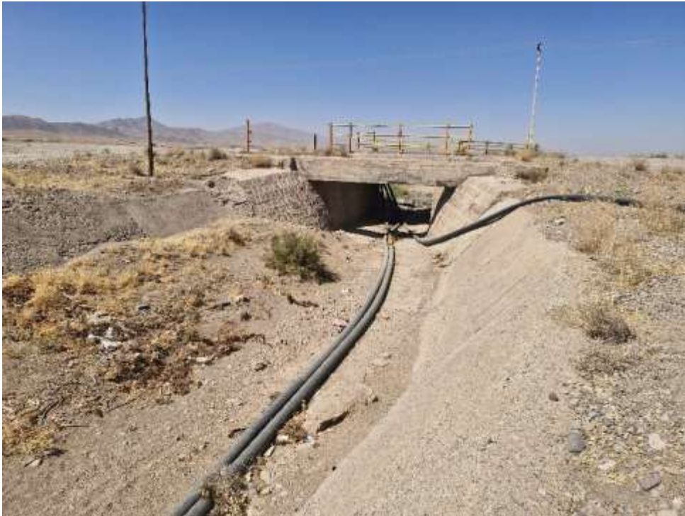
شکل ۱۸- تصویری از سازه پل (زیرگذر) احداث شده بر روی کانال آبرسان در فاصله یک کیلومتری از محل آبیگیری از رودخانه حاجی عرب
