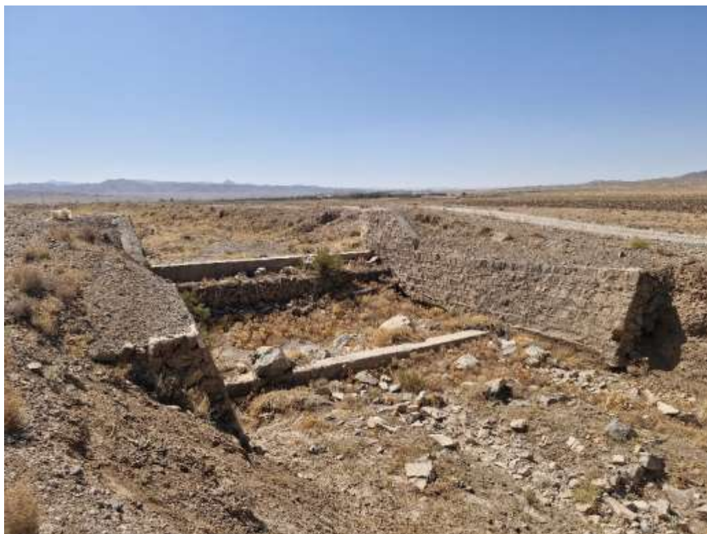
شکل ۱۷- تصویری از سازه‌های شیب‌شکن احداث‌شده در داخل کانال آبرسان و تغییرات صورت‌گرفته در
