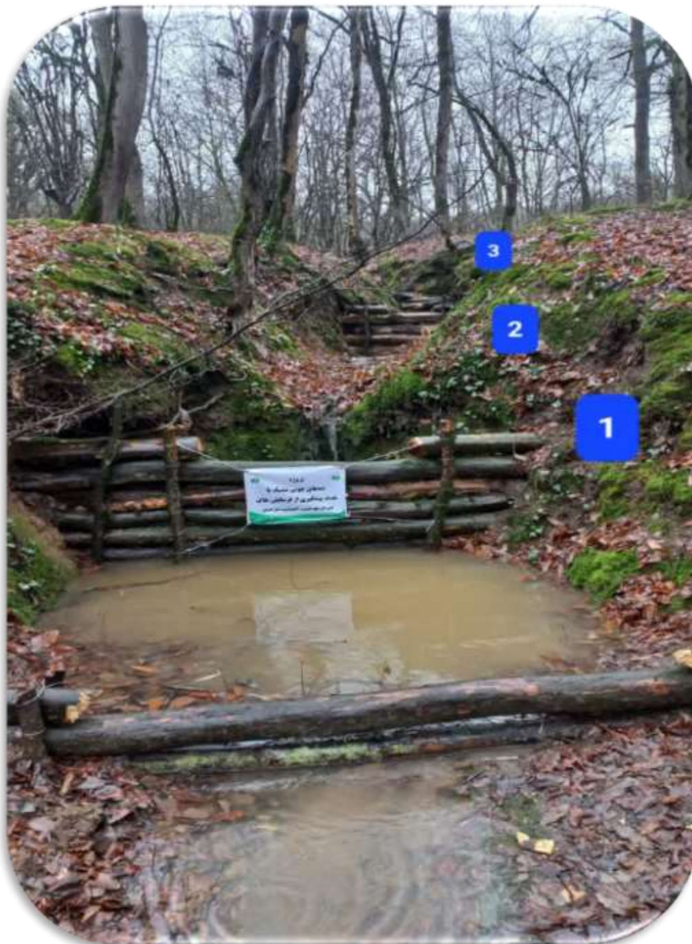
شکل ۳-۱۱. اجرای پروژه‌های مدیریت سیلاب و کنترل رسوب از نوع اقدامات همسو با طبیعت به منظور تثبیت گالی فعال در حوزه آبخیز النگدره- شهرستان گرگان (روابط عمومی اداره کل منابع طبیعی گلستان- ۱۴۰۳)
