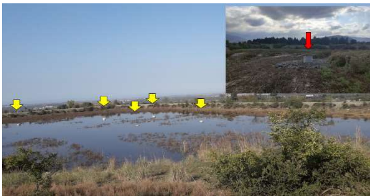
شکل ۳-۴. اثربخشی پروژه آبخیزداری و آبخوانداری (سیلت‌زدایی و چاه تغذیه آبخوان) نوکنده، شهرستان
