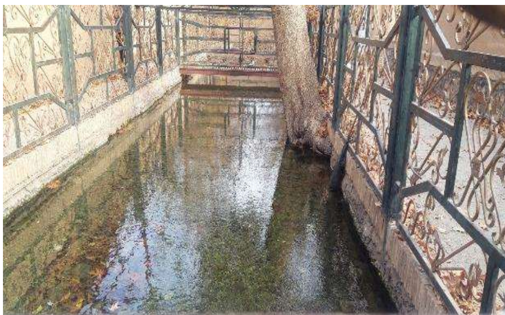
شکل ۱۴- حصارکشی اطراف نهر انتقال آب قنات گوه‌رریز
