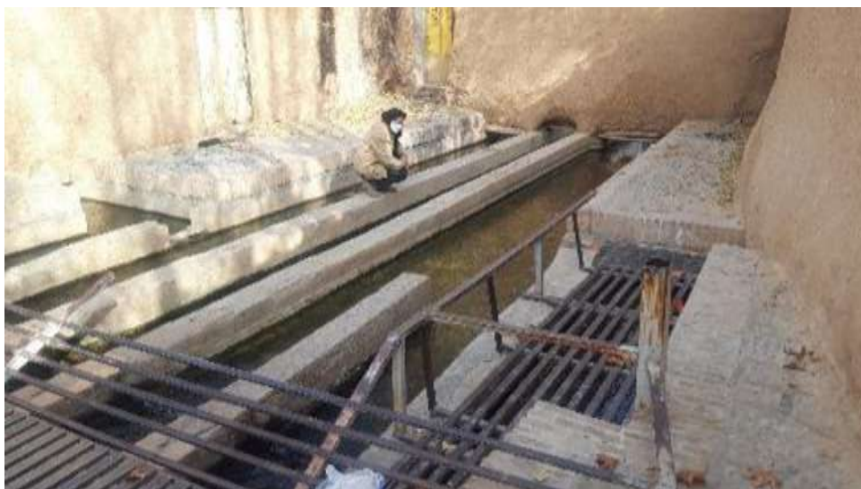
شکل ۱۱- نهر انتقال آب از قنات گوهرریز معروف به شش مقسم
