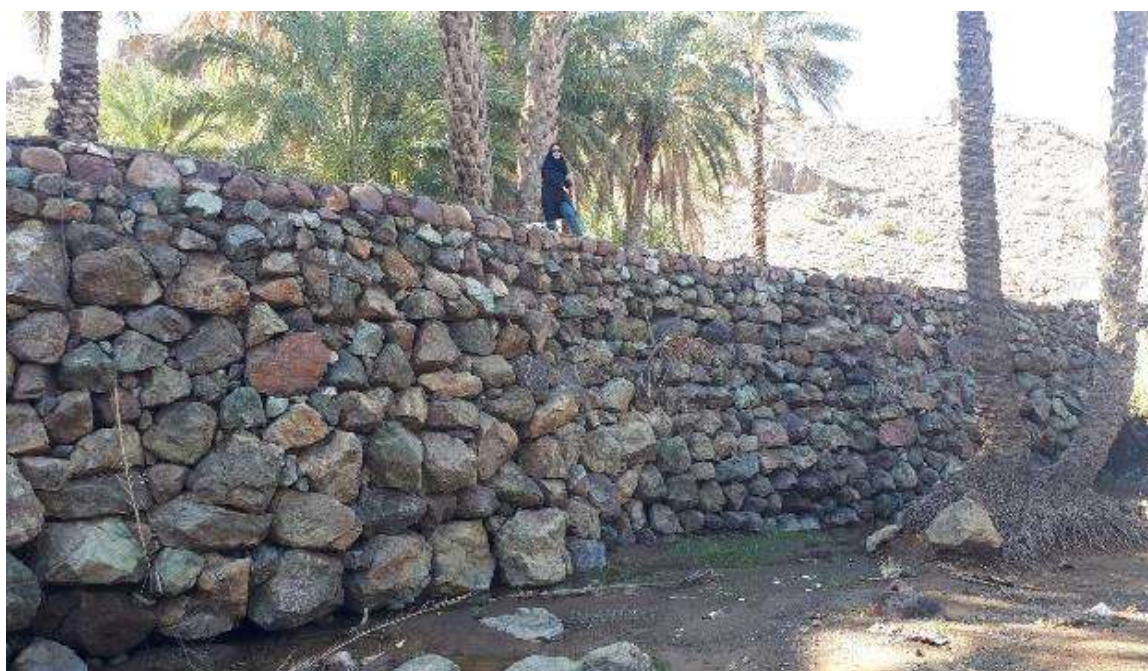
شکل ۵- نمای کلی از سازه دربند در مسیر رودخانه
